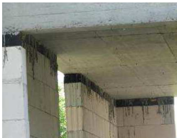
Obr.7: Správné řešení detailu napojení vodorovné a svislé izolace pomocí KS-ISO Kimmsteine v úrovni podlahy a nebo pomocí deskového pěnokla v úrovni stropu nad nevytápěnou garáží. Vynechání pěnokla, nebo jiného izolantu v tomto detailu by bylo vážnou projekční chybou.
