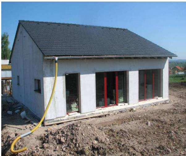
Obr.6: Pasivní přízemní RD 121 m 2 zastavěné plochy je s 15 kWh/m 2 rok na samé hranici možností dosažení PD v ČR.
