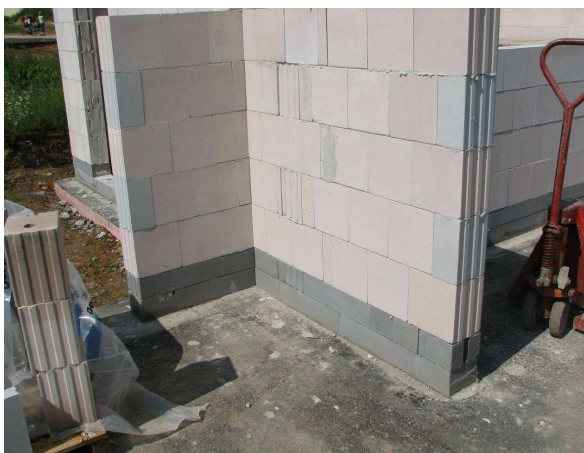
Obr.7: Správné řešení detailu napojení vodorovné a svislé izolace pomocí KS-ISO Kimmsteine v úrovni podlahy a nebo pomocí deskového pěnokla v úrovni stropu nad nevytápěnou garáží. Vynechání pěnokla, nebo jiného izolantu v tomto detailu by bylo vážnou projekční chybou.
