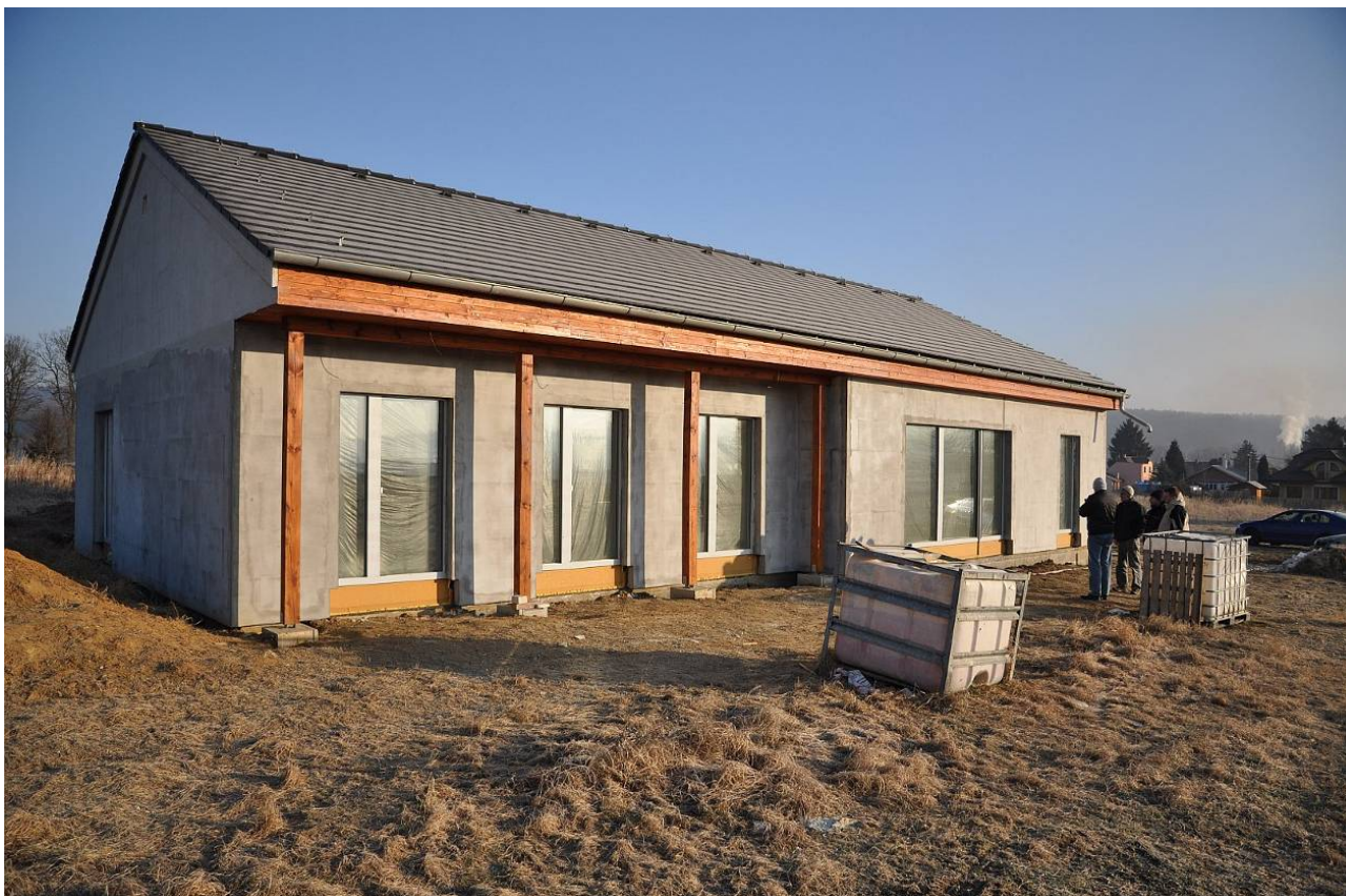
Nízkoenergetický dům Štáhlavice ve výstavbě.
